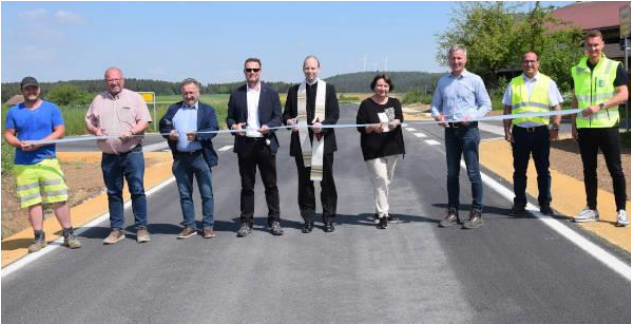
Der Ausbau der Ausfahrt Malsbach-Nord wurde ebenfalls heuer abgeschlossen.
